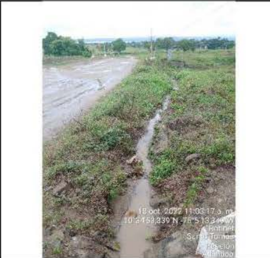
FOTO No. 9 Tomada el 18 de octubre de 2022 Observaciones: canales en tierra observados en la cantera, no están estructurados ni poseen mantenimiento.
